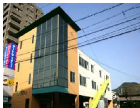
社会福祉法人アス・ライフ 本部 平成 22 年 2 月 26 日竣工
